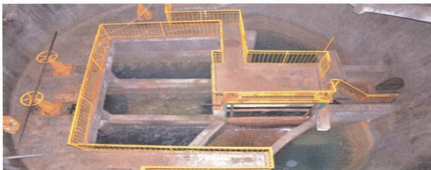
Interior dren nou Timișești
